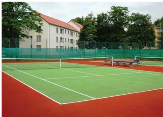
Idéal pour les aires de jeux, terrains multisports, le SOL COULÉ GAROCHUT® est coulé d'un seul tenant et s'adapte à la hauteur de chute de la structure. Il est antidérapant. Avec 12 couleurs, vous pouvez créer des sols antidérapants très créatifs. Conforme à la norme NF-EN1177. Le SOL COULÉ permet un confort acoustique, une perméabilité, une durabilité et un esthétisme.
