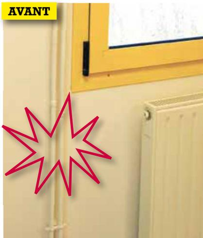
Les conduits de radiateur peuvent provoquer des blessures de part leur système de fixation mais également des brûlures.
